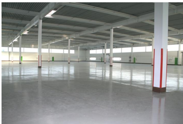
Halle trotz ausgeschalteter Beleuchtung hell
